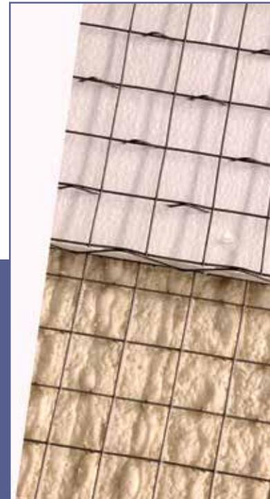
El **Panel MG** es un panel constructivo modular, consiste en una estructura tridimensional de alambre de acero pulido al bajo carbono (1008), normas ASTM A-82, A-85, A-370 y A-510, calibre 14 ó 13, conformada por armaduras de dos alambres paralelos electrosoldados a un tercero en forma de zigzag conformado así retículas en la parte inferior y superior del Panel MG.
